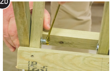
Sett på skiver og skru fast låsemuttere
