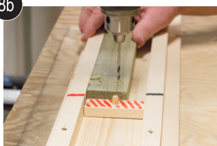
8b Bore skruenhull i alle støtteben, posisjon rødt
