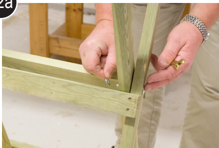
Sett på skiver og skru fast låsemuttere
