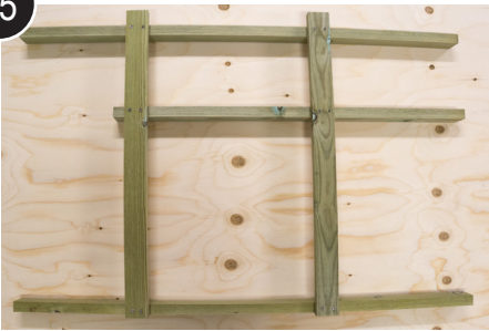
Ferdig montert side 1
