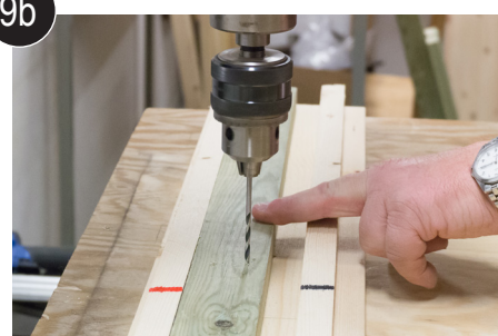
9b Bore skruenhull i 2 tverrstøtter for støtteben, side 1
