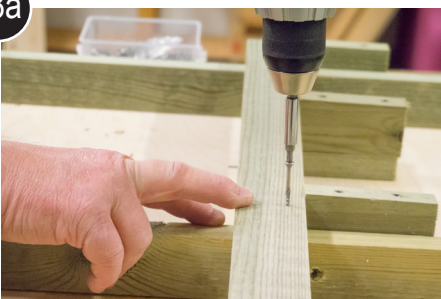
Skrue fast tverrstøtter til ben og støtteben
