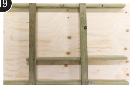
Ferdig montert side 2
