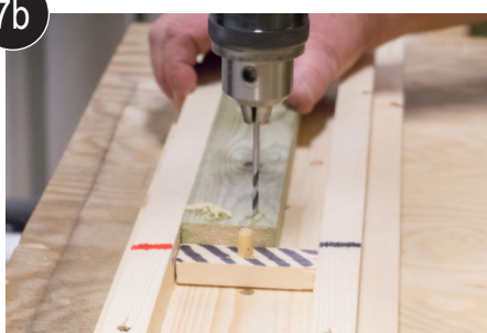
7b Bore skruenhull i alle støtteben, posisjon sort
