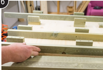
Ben og støtteben i monteringsjigg – side 2
